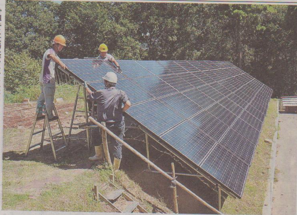
骨組みに太陽光パネルを設置する参加者。坂井市三国町陣ヶ岡
